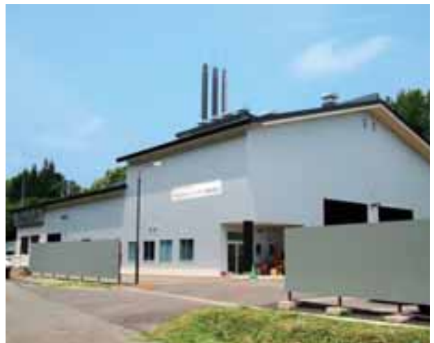
村山市富並のバイオマス発電所
